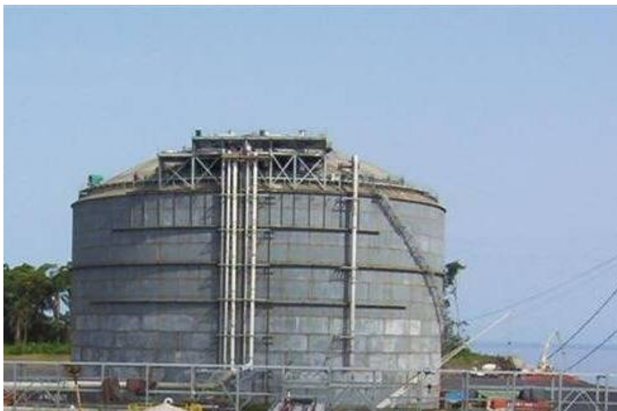
An LNG storage facility
